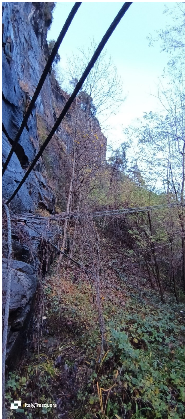
C) Sentiero lungo la parete con corde per le rete contro la caduta massa
