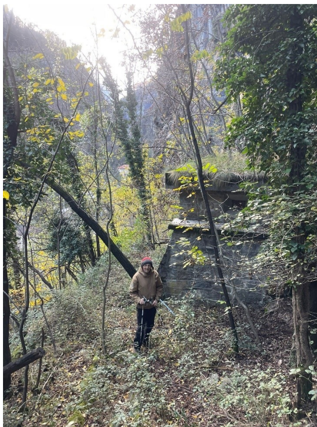
B) Sentiero vicino di un serbatoio dell'acqua
